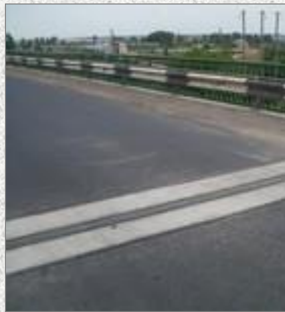
Деформационные швы закрытого типа
