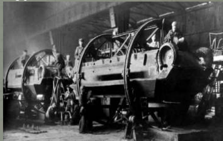
Сварка под флюсом основного корпуса танка
