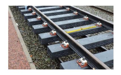
В разных странах мира разработан ряд технологий изготовления полимерных шпал. Эти технологии стали альтернативой потенциальной деревянным шпалам. В отличии от стали и бетона, полимерные шпалы можно спроектировать таким образом, чтобы они имитировали поведение древесины. При этом рельсовый путь с деревянными шпалами требует обязательного технического обслуживания, а полимерные шпалы практически его не требуют и более рациональны с экологической точки зрения.
